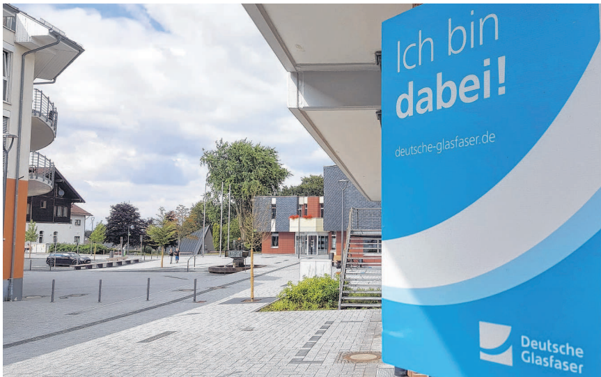
Das schnelle Internet hält so langsam Einzug in der Gemeinde Simmerath. Am 30. Juli soll mit den Tiefbauarbeiten zeitgleich in Simmerath und Lammersdorf begonnen werden. Foto: Hoffmann
